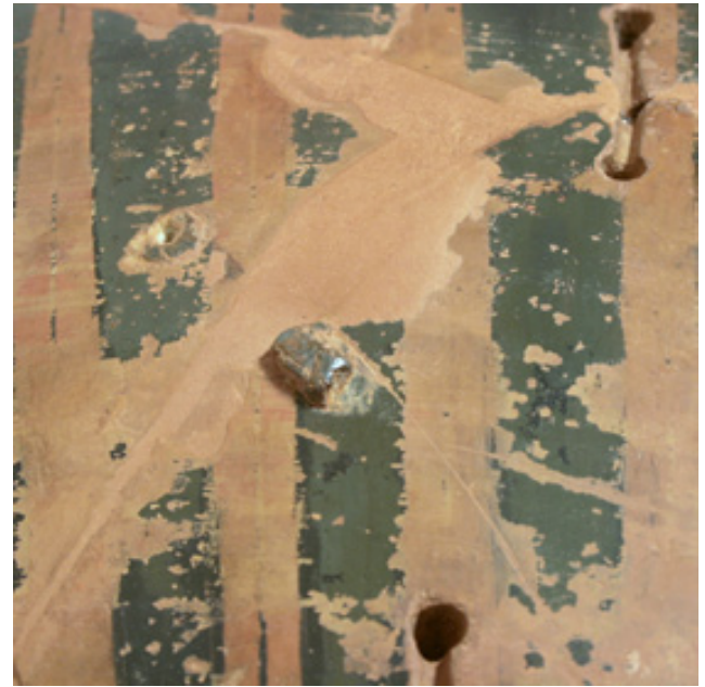
Prima del restauro, particolare, resti della grappa in piombo e alloggiamenti per grappe metalliche
