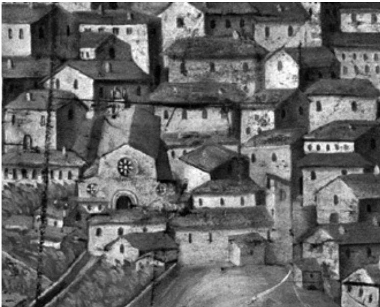
Giovan Paolo Cardone, Gonfalone della città dell'Aquila , 1579, L'Aquila, Museo Nazionale d'Abruzzo: nel particolare è visibile, a sinistra, la chiesa di San Domenico, nelle condizioni antecedenti al sisma del 1703
