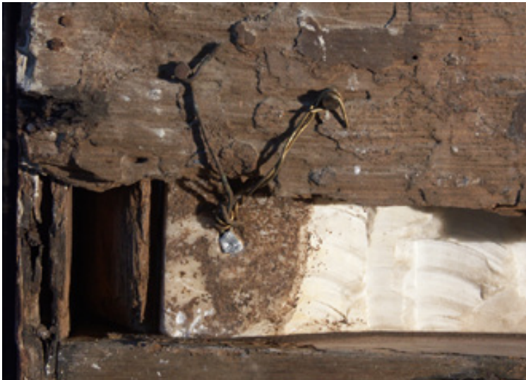
Prima del restauro, particolare del sistema di ancoraggio delle lastre alla struttura lignea
