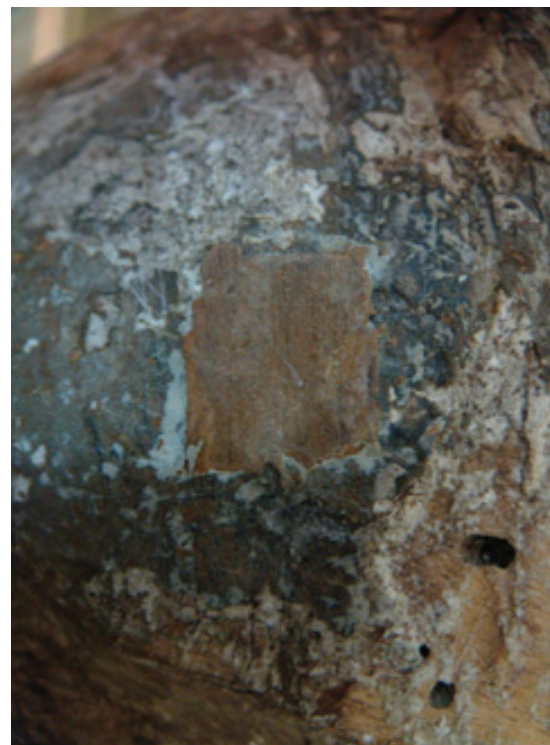
Durante il restauro, particolare, tassello di pulitura
