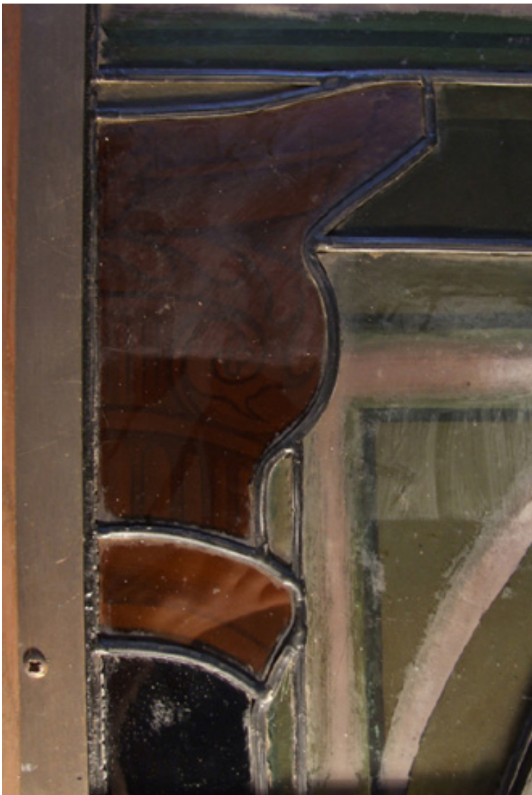
262 Durante il restauro, particolare, tassello di pulitura
