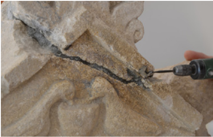
Durante il restauro, rimozione delle sigillature cementizie del timpano
