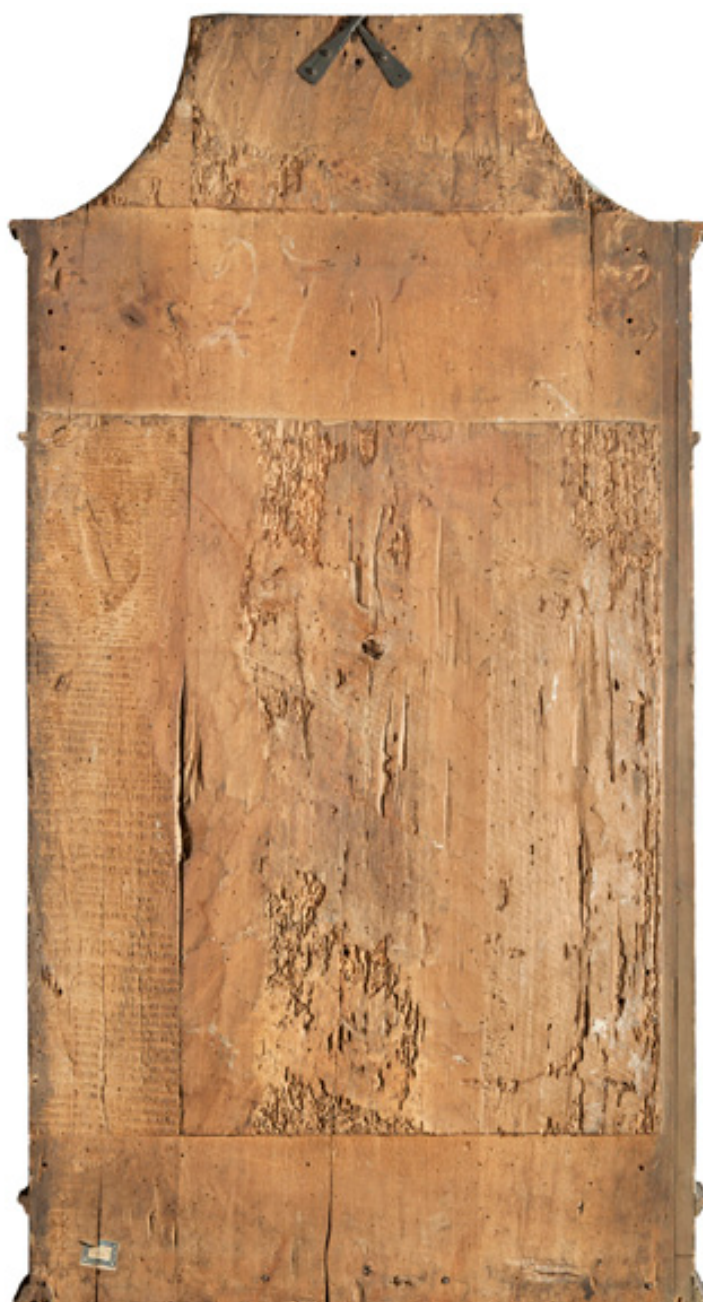
Prima del restauro, retro
