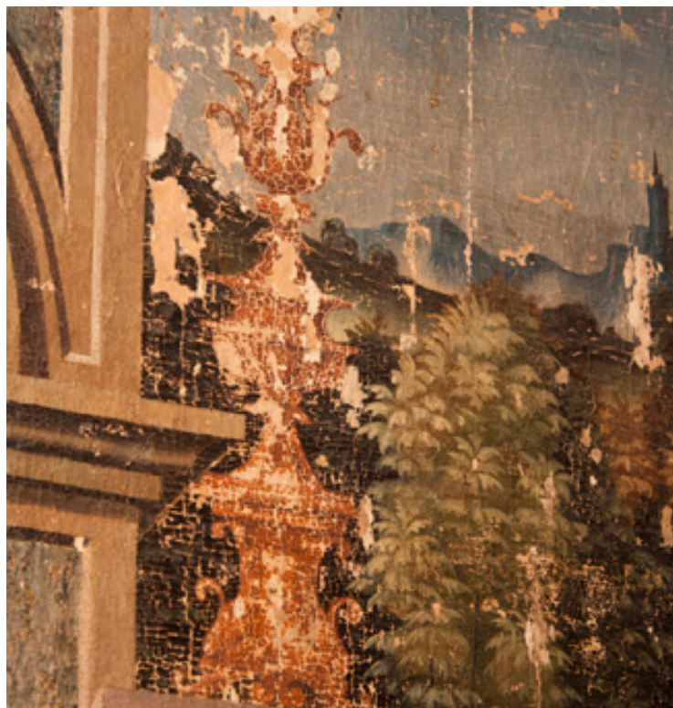
Prima del restauro, particolare dello sfondo e del trono, stato di conservazione del film pittorico
